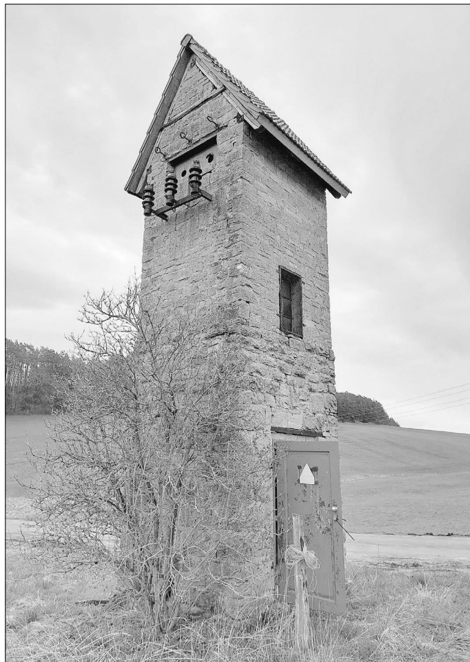
Trafostation vor Instandsetzung
